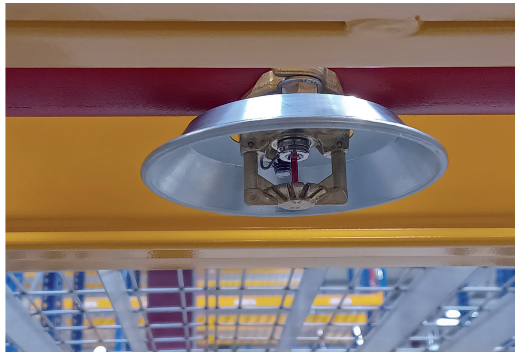
◀ Beim QuickFit-Sprinkler kann die Abschirmhaube nachträglich montiert oder bei Beschädigung einfach gewechselt werden. Foto: Fire Protection Solutions
