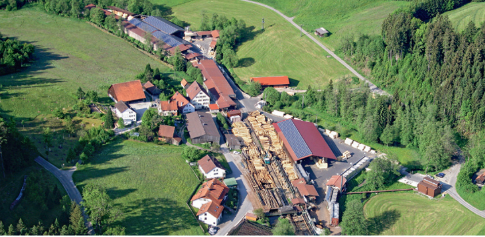
Im Sägewerk Kolb installierten die Brandschutzexperten von GFA aus Gelnhausen eine Sprinkleranlage
