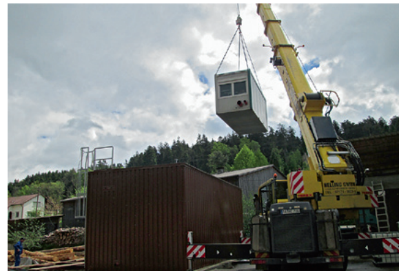
Die Wasserversorgung erfolgt über einen Stahlvorratsbehälter mit 140 m 3
