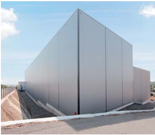
Das neue Hochregallager überragt das bestehende Gebäude um mehr als 11 m
