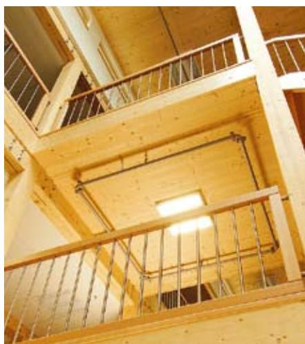
*Auf dem Foto sind die Sprinklerrohre zu erkennen, die zugleich als innenarchitektonische Elemente an der Decke fungieren.*
