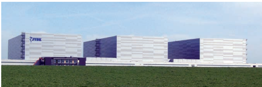
75.000 Sprinkler: Das Zentrallager der JYSK-Gruppe ist mit umfassendem Brandschutz gesichert. Bild: Calanbau
