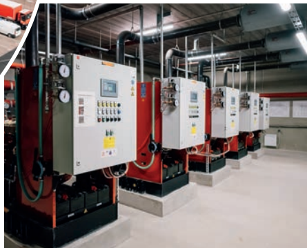
Die Wasserversorgung der Sprinkler- und Hydrantenanlage wird durch fünf Dieselpumpenaggregate gesichert
